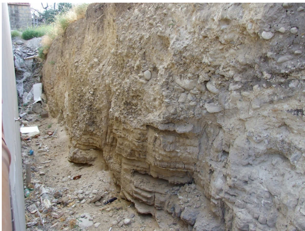
Figura 17 - Conglomerati in matrice sabbiosa in discordanza su livelli e strati di sabbie laminate (Nuova costruzione lungo la SS 161 Centro Abitato)
